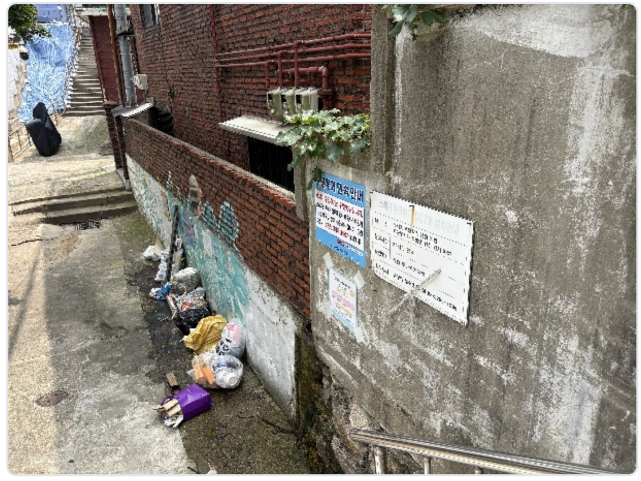
【사진2】주택 밀집 골목 악취 및 위생 환경
