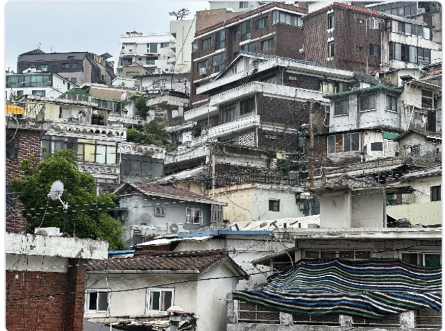
【사진4】경사면 따라 밀집된 노후 주택 전경
